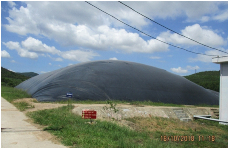
Hình 6: Biogas bạt HDPE
